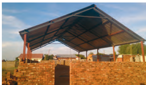
Voorbeeld van de constructie die ook in Letlabile gehanteerd wordt: eerst het dak op een stalen frame, vervolgens de muren eromheen.
